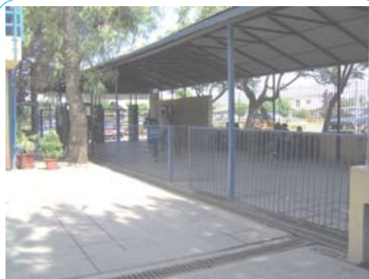
Foto 9 ANTES: Entrada a la escuela sin supervisión.
