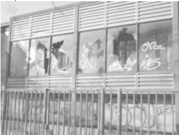
Utilizar materiales como policarbonato en vez de vidrio para ventanas, disminuye la vulnerabilidad del blanco.
